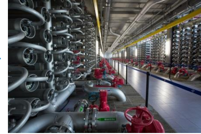
Mery-sur-Oise plant : nanofiltration
